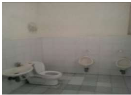
ÁREA BAÑOS 1ER. PISO
