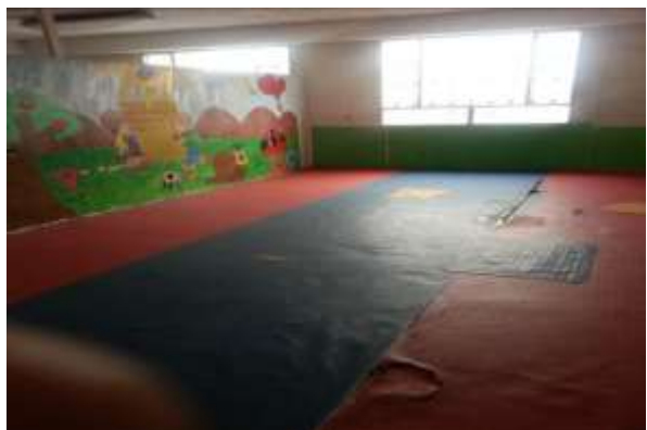
ÁREA SALÓN 2° PISO – INUTILIZADO
