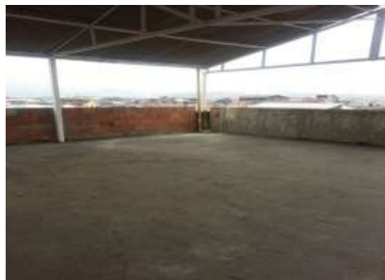
TERRAZA SIN VIDRIOS DE SEGURIDAD 4° PISO
