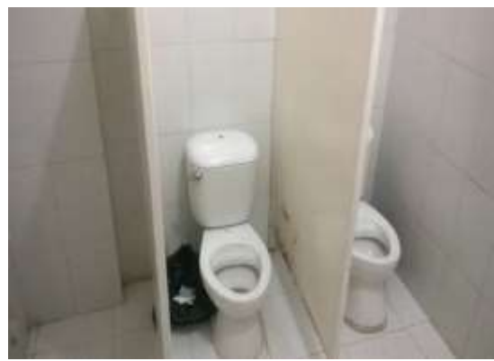
ÁREA BAÑOS 1ER PISO CON MALOS OLORES
