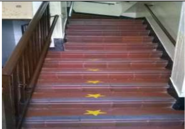
ESCALERAS EMPINADAS Y ANGOSTAS
